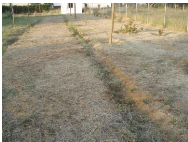
"Estado actual del jardín con las zanjas para los bordillos".
